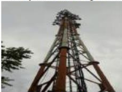
extendido de cables
