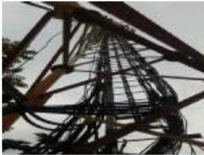
Torre y Sistema de seguridad
