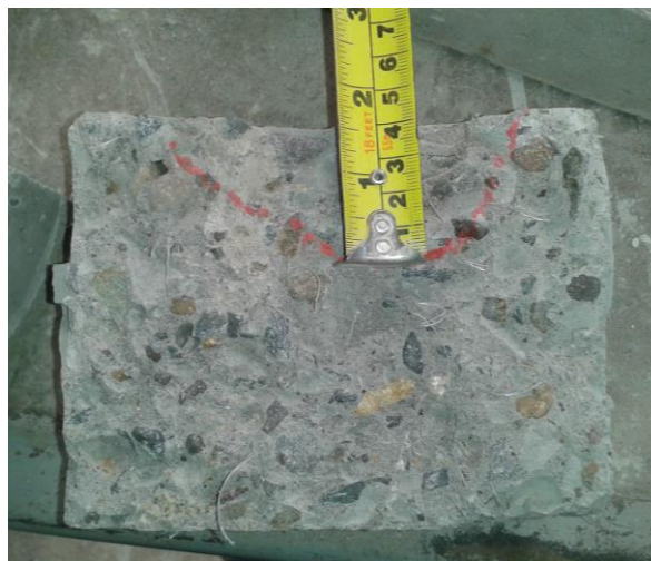
Figura 5.17: Medición de la Penetración de Agua
