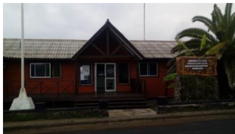
Fig. nº 34: edificios de administración pública.
