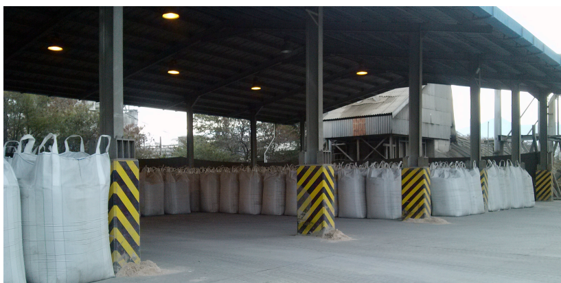
Figura III.5.3: Bodega de almacenamiento de bigbags, Cemento Melón, Planta La Calera.
