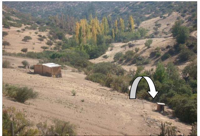
Se puede apreciar el sistema de Eliminación de excretas – Pozo Negro.
