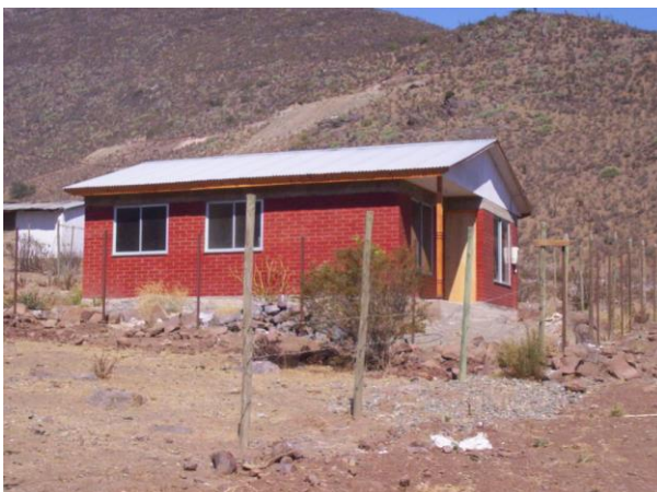
Construcción de Viviendas Sociales – La Chimba
