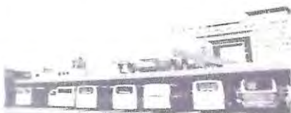
Vistas del área de estacionamiento de buses
