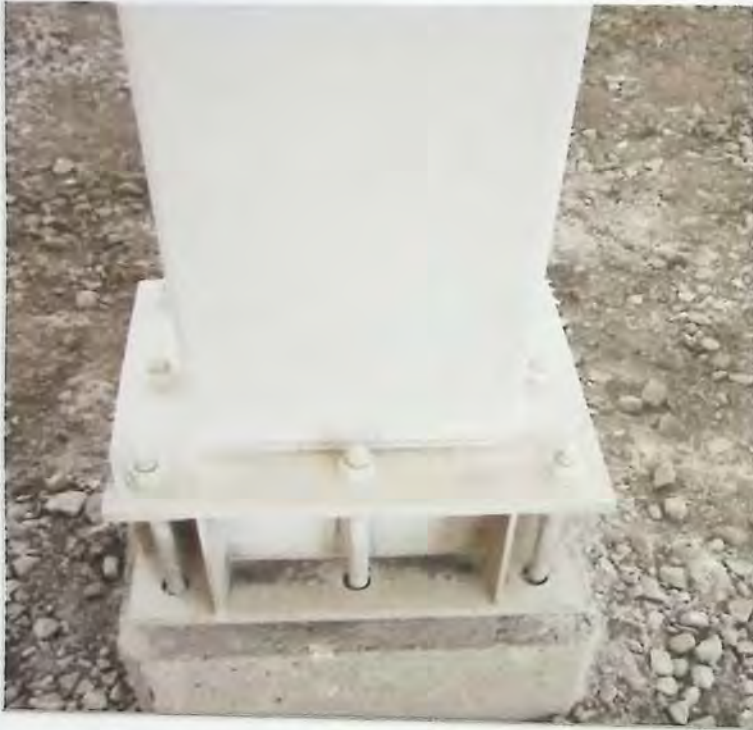
Figura 4.3: Imagen referencial pernos de anclajes.
