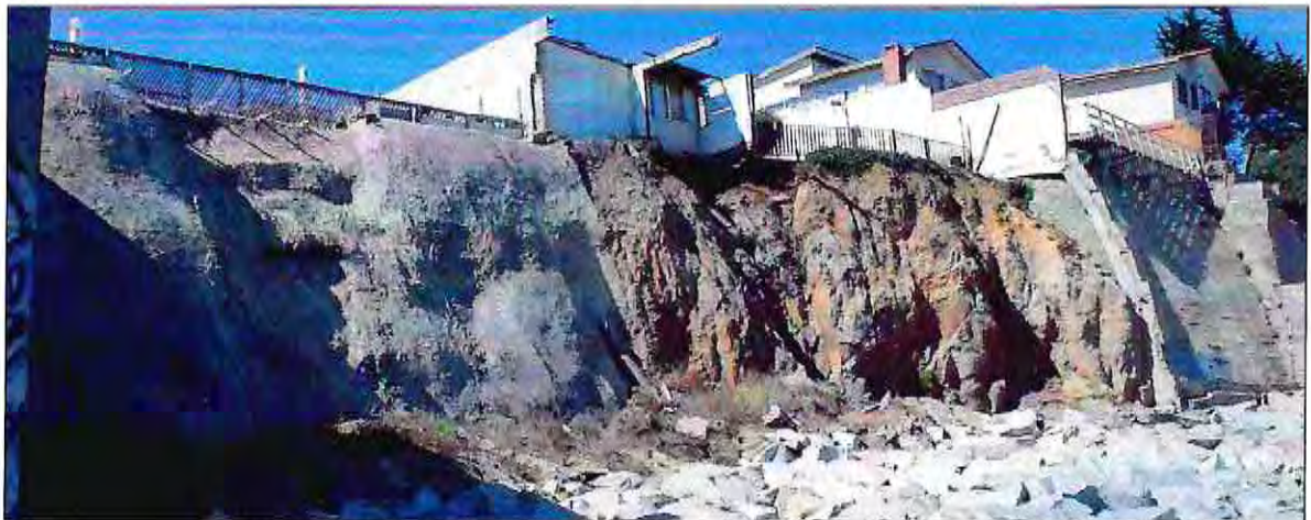
Figura 52: Vista general de una de las zonas dañadas en la playa. (Fuente: Elaboración Propia).
