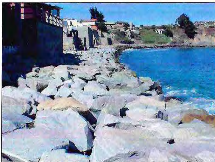
Figura 54: Protección de fondo construida al pie del talud. (Fuente: Elaboración Propia).
