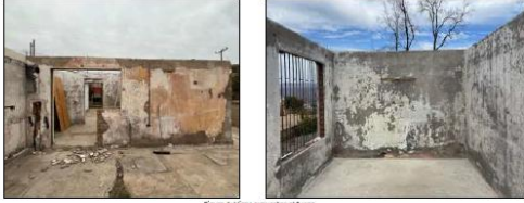
Figura 1: Vigas expuestas al fuego
