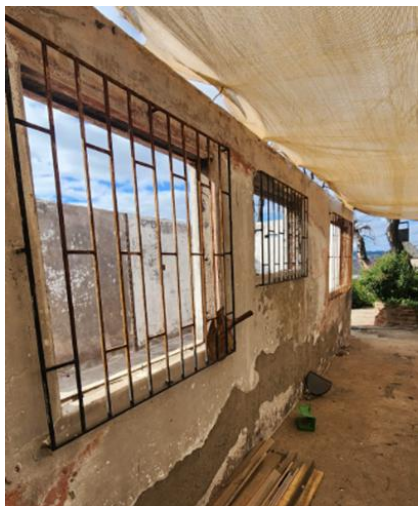
Protecciones de ventanas sin signos de derretimiento
