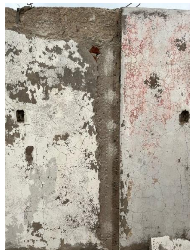
Pilar y parte de cadena sin revestimiento
