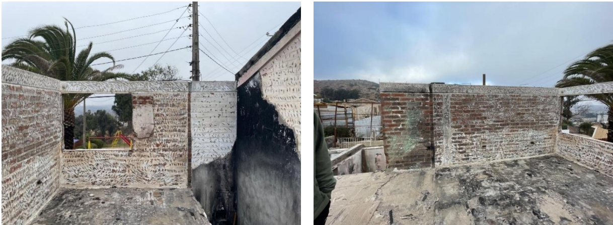
Estructuras segundo piso
