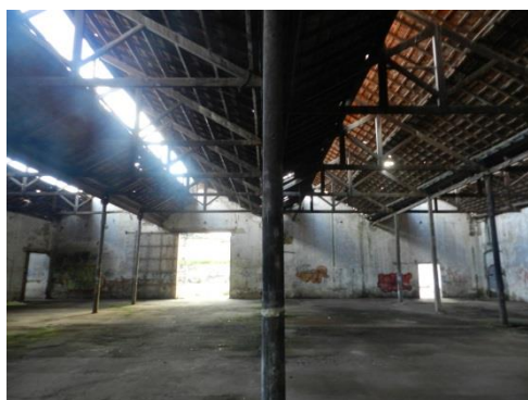
Cobertura tipo shed, um sistema para iluminar ambientes, Fabrica de Tecidos de São Carlos
