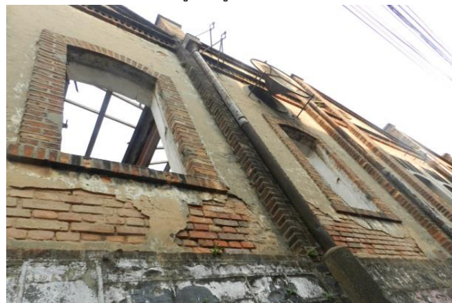
Fachada Este de tijolos da Fabrica de Tecidos São Carlos
