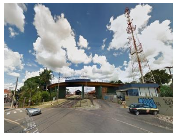
Paso sobre nível, próximo Estação do São Carlos.
