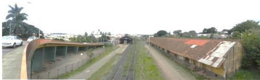
Situação Existente, Área Ferroviária
