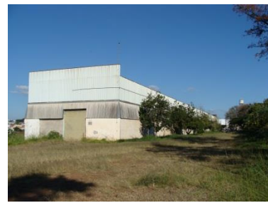
Situação Existente, Galpão Pré-existente, Área Ferroviária
