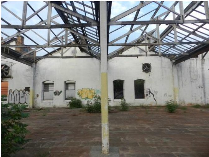
(84) Relatório Defesa Civil de São Carlos Pavilhões descobertos Piso de Concreto, Fabrica de Tecidos de São Carlos
