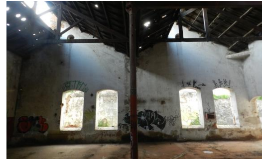
Área Interna, setor armazenamento, Fábrica de Tecidos de São Carlos
