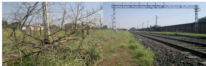
Situação Existente, Área Ferroviária
