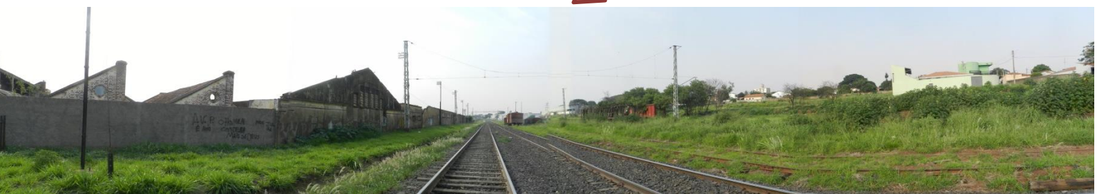
Situação Existente, Área Ferroviária
