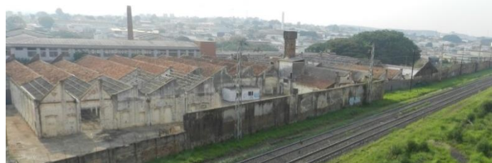
Imagem aérea Fabrica de Tecidos São Carlos
