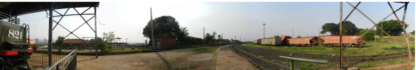
Situação Existente, Área Ferroviária
