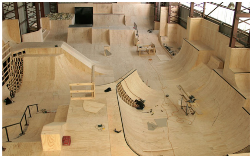
36. Sistema de plataformas indoor en proceso de construcción
