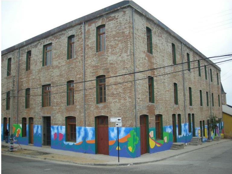
REHABILITACIÓN EDIFICIO POBLACIÓN OBRERA
