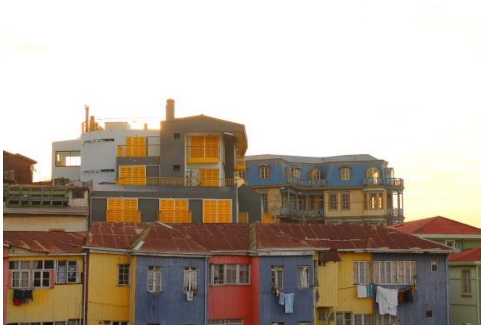
Ilustración 209, Nueva edificación con exceso de protagonismo, Cerro Bellavista. 454
