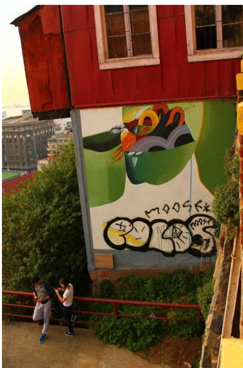
Ilustración 185, Daños sobre Mural 9 de Rodolfo Opaço. 385
