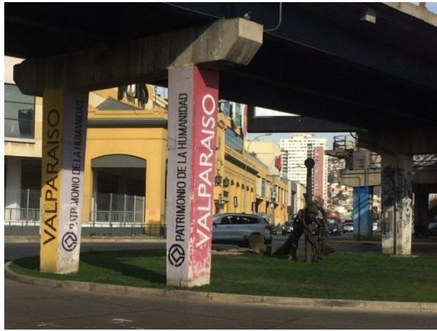
Ilustración 214, Obras sobre los pilares del nudo Barón, Sector Muelle Barón, Valparaíso.
