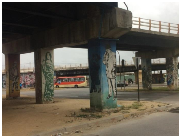
Ilustración 215, Obras sobre los pilares del nudo Barón, Sector Muelle Barón, Valparaíso.
