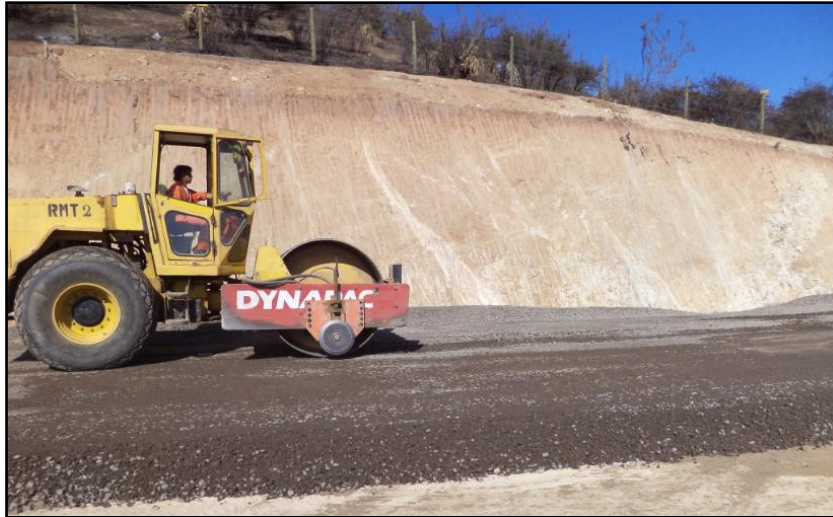
Figura 4.8.- Preparación de la cancha de pruebas de base granular nº 2
