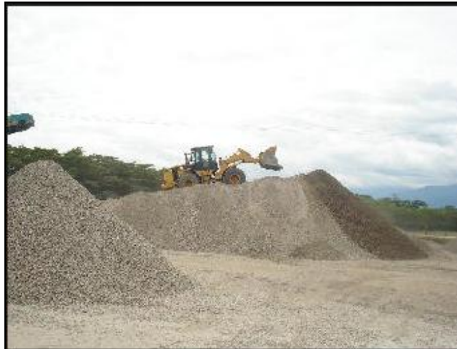
Figura 4.3.- Obtención de la muestra de base granular n° 2
