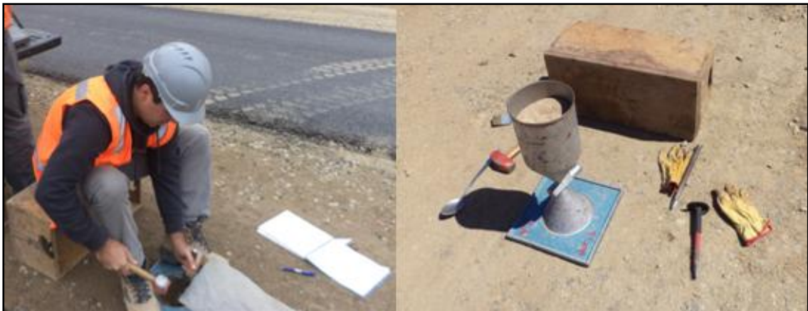
Figura 3.4.- Control de compactación en terreno con el método del cono de arena
