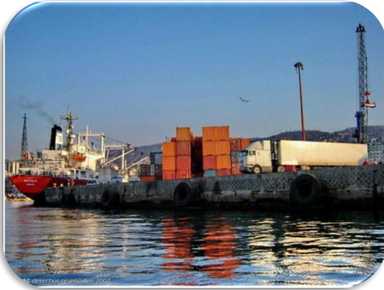
Figura N° 21: Sitio 6 de Terminal 2, EPV
