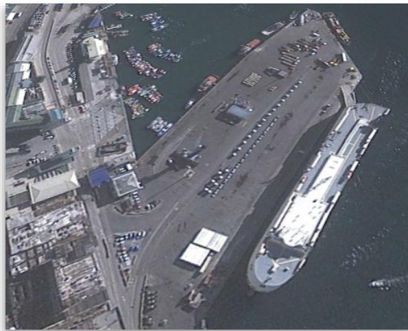
Figura N°1: Imagen aérea de Puerto de Valparaíso Terminal N°2.
