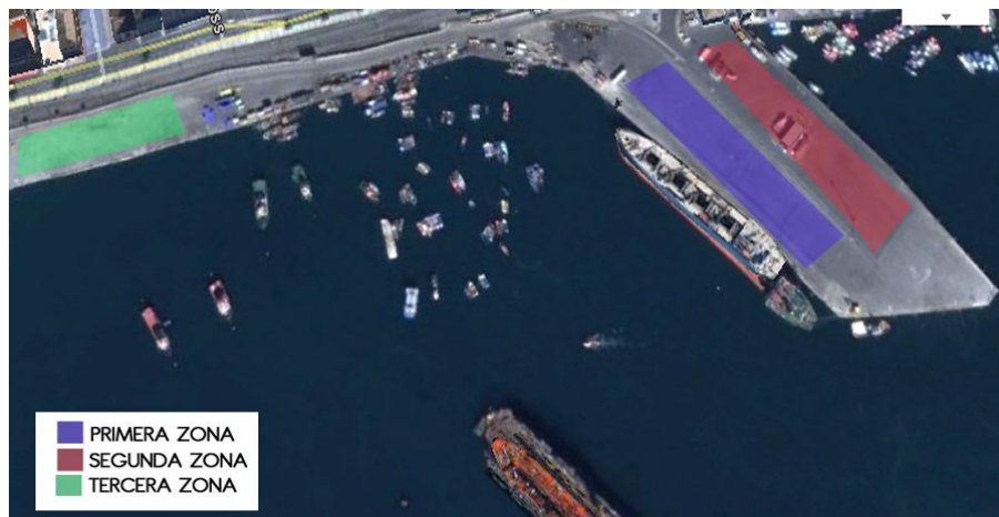
Figura 16: Vista aérea división puerto de Valparaíso por zona Comercial.
