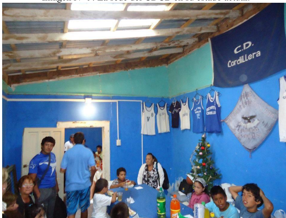
Imagen N° 9: La sede del CDCB en su estado actual.
