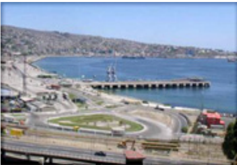
FIGURA 30 Vista borde costero – Muelle Barón FUENTE Plataforma urbana
