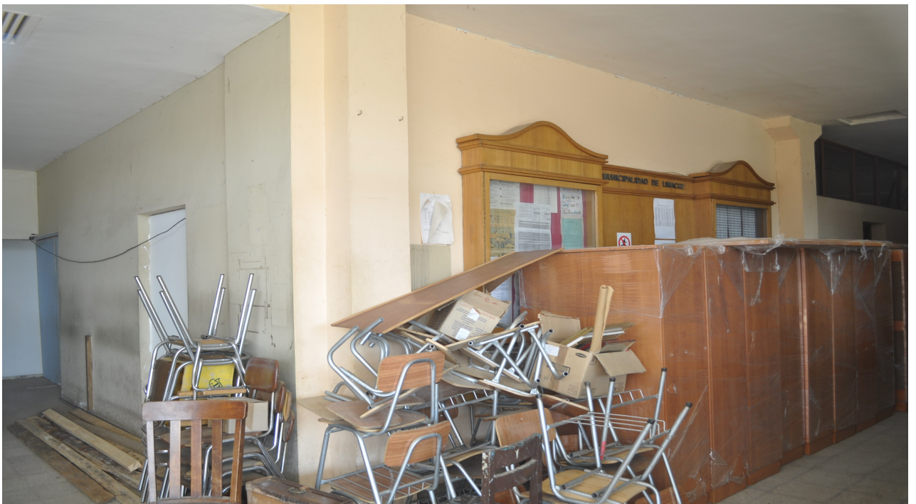
Ejemplo de cómo el edificio funciona actualmente como una bodega
