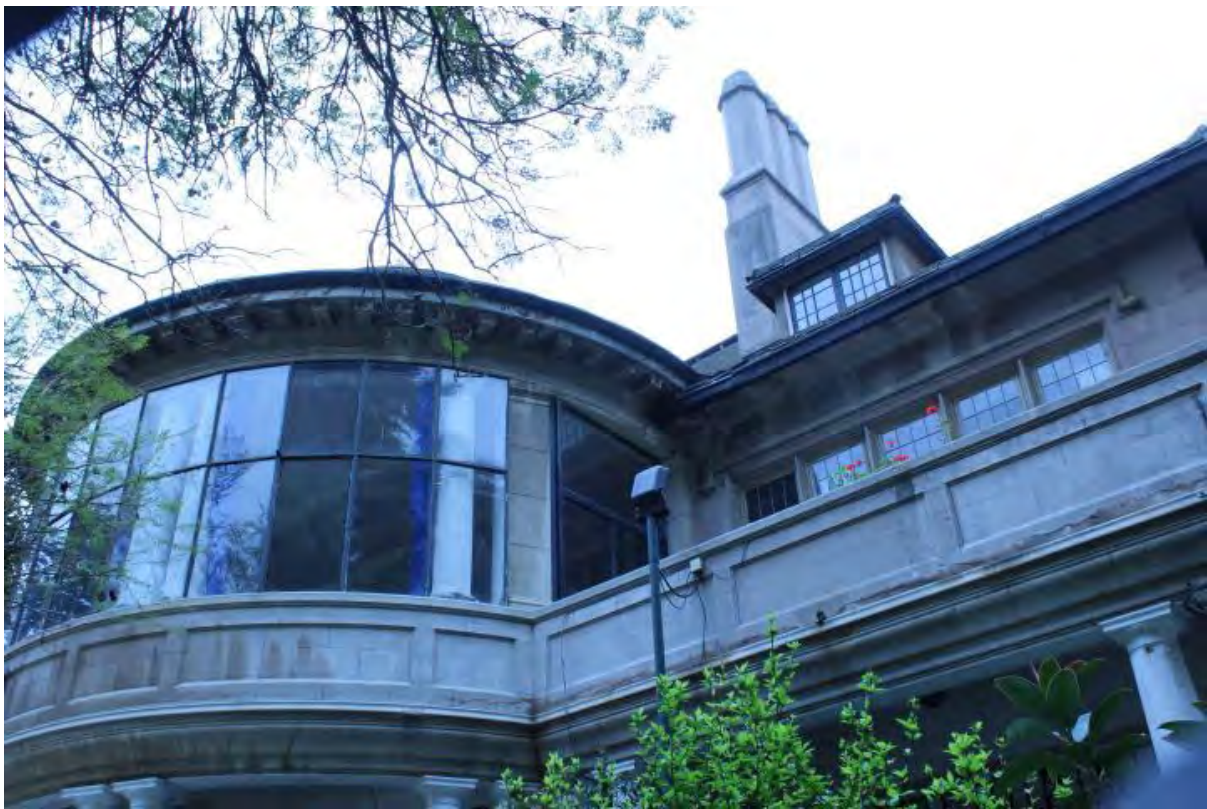
CMN. (s/f) Fachada sur terraza techada segundo piso (Fotografía) Extraído de: https://www.monumentos.gob.cl/monumentos/monumentos-historicos/casa-italia
