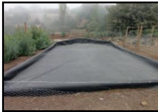
FIGURA N° 53: ÁREA DE CAPTACIÓN TERMINADA. FUENTE: MANUAL DE DISEÑO Y CONSTRUCCIÓN DE SISTEMAS DE CAPTACIÓN DE AGUAS LLUVIAS EN ZONA RURALES DE CHILE, 2015.
