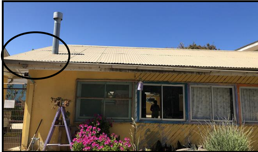
FIGURA N° 28: INCLINACIÓN DEL ÁREA DE CAPTACIÓN DEL ESTABLECIMIENTO.
