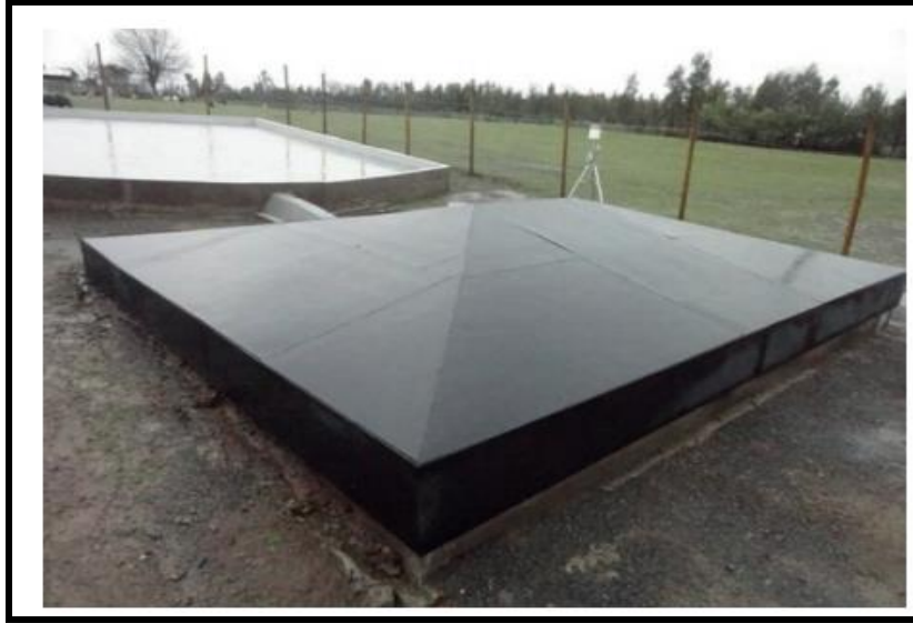
FIGURA N° 7: ESQUEMA DE UN SISTEMA DE CAPTACIÓN Y ACUMULACIÓN DE AGUAS LLUVIAS DE LADERA. FUENTE: MANUAL DE DISEÑO Y CONSTRUCCIÓN DE SISTEMAS DE CAPTACIÓN DE AGUAS LLUVIAS EN ZONA RURALES DE CHILE, 2015.
