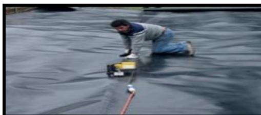
FIGURA N° 50: FUSIONADO DE LA GEOMEMBRADA. FUENTE: MANUAL DE DISEÑO Y CONSTRUCCIÓN DE SISTEMAS DE CAPTACIÓN DE AGUAS LLUVIAS EN ZONA RURALES DE CHILE, 2015.
