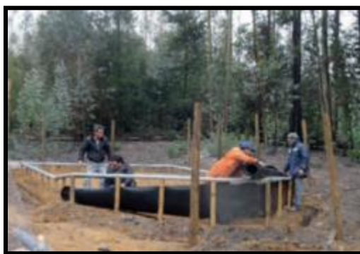
FIGURA N° 51: SELLADO Y SOLDADO DE LA GEOMEMBRANA. FUENTE: MANUAL DE DISEÑO Y CONSTRUCCIÓN DE SISTEMAS DE CAPTACIÓN DE AGUAS LLUVIAS EN ZONA RURALES DE CHILE, 2015.
