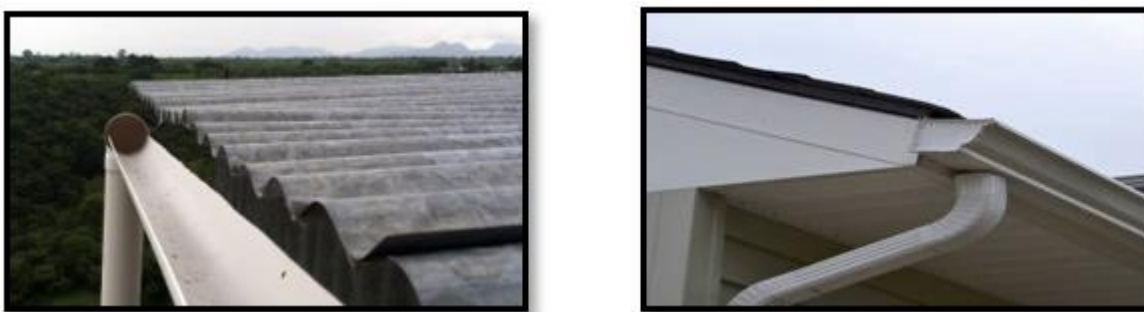
FIGURA N° 29: SISTEMAS DE CANALETAS PARA UTILIZAR COMO SISTEMA DE RETENCIÓN. FUENTE: AGROTECNIA, 2019.
