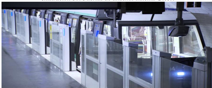
Ilustración 16: Puertas de andenes sistema GoA4.
