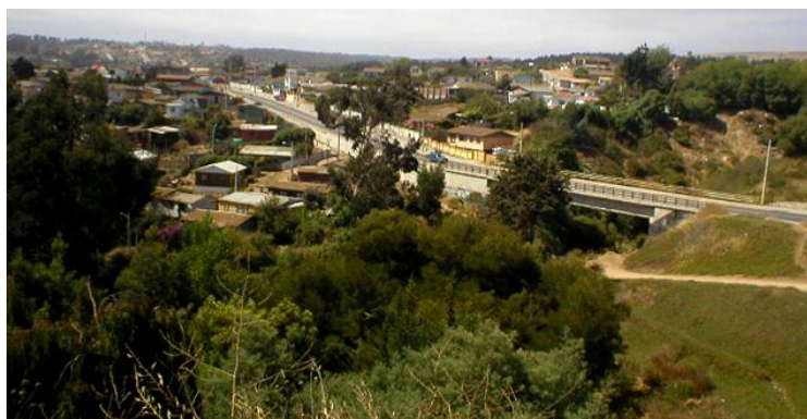
Vía Transversal elevada sobre el caudal hídrico-verde del Estero La Cigüeña. Av. El Peral, Cartagena.
