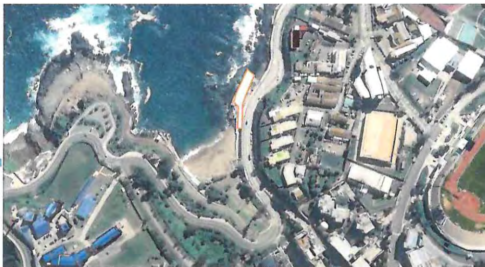
TORPEDERAS Y PISCINAS EN DETERIORO
