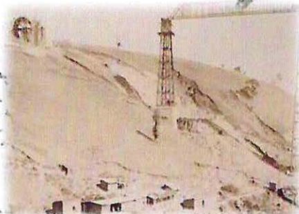
Proceso de construcción del viaducto sobre el río malleco
