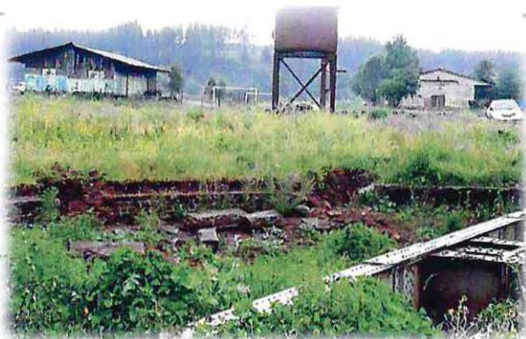
Ruinas tornamesa estación de Mulchen
