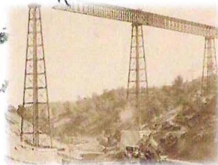
Culminación de las obras con la postura del último tramo de viga
