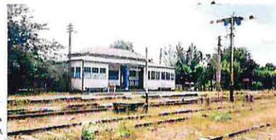
Estación Perquenco, situación actual
