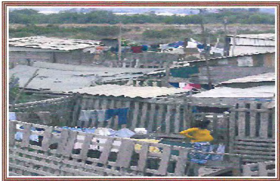
Foto Nº 3: Sector Población El Esfuerzo
