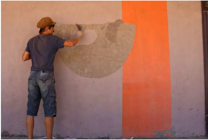
Imagen 35. Removimiento de pintura, primera etapa de preparación del soporte. ©Margarita Cáceres
