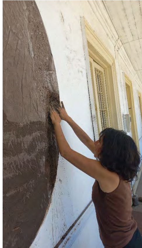
Imagen 37. Reparación de grietas del soporte. ©Sebastián Fuentes
