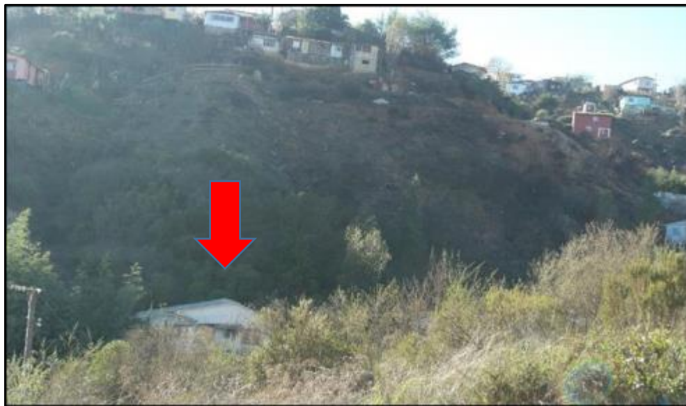
Figura 57: Viviendas ubicadas cerca del cauce de la cuenca.
