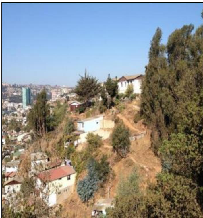
Figura 54: Viviendas ubicadas en áreas desprovistas de vegetación en laderas de gran pendiente.
