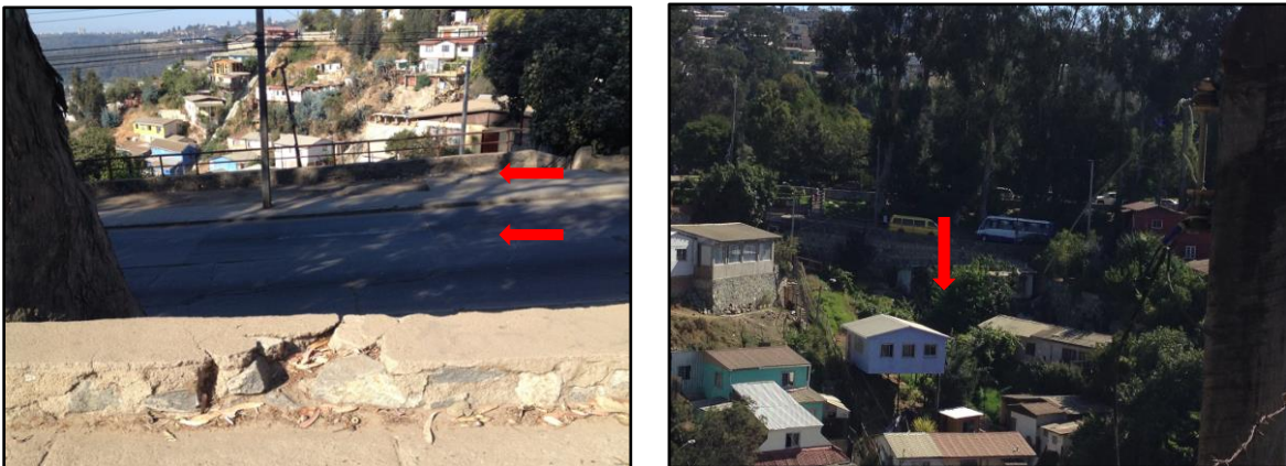
Figura 23: Fotografías del pretil de contención.
