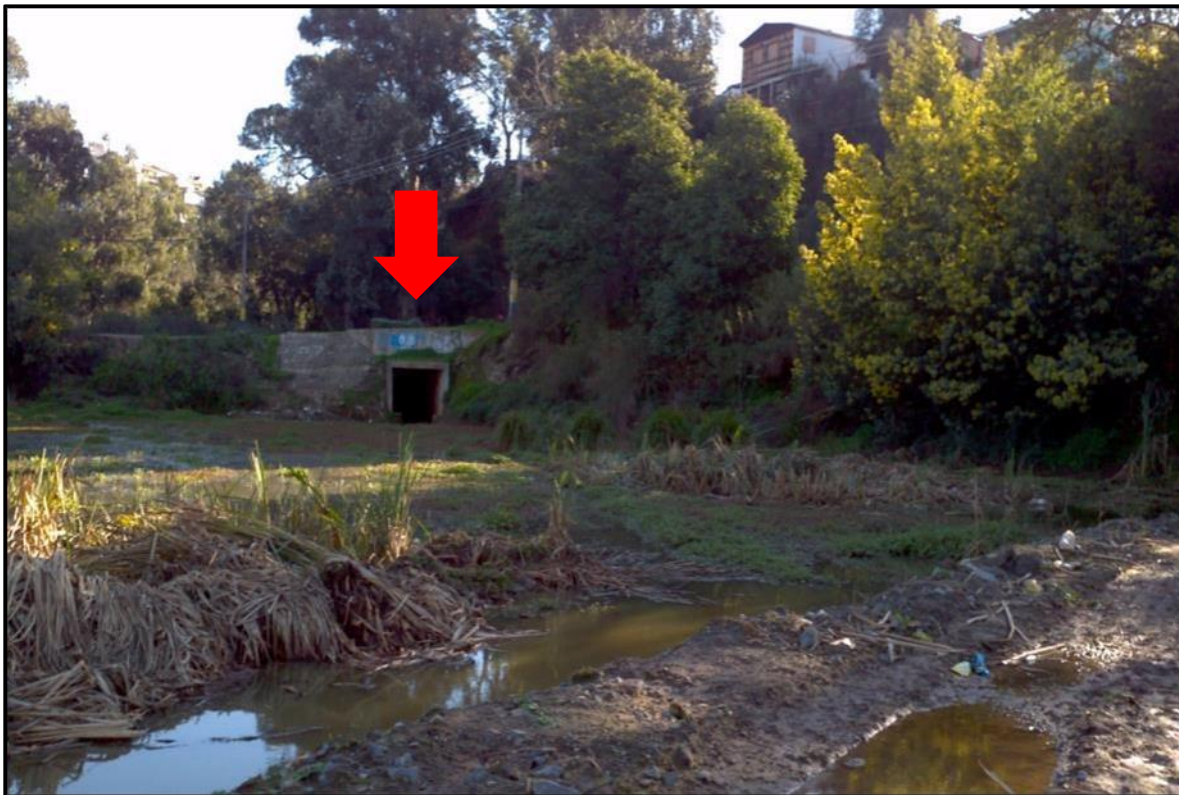
Figura 74: Tranque Forestal, vía de evacuación de agua hacia la Quinta Vergara.
