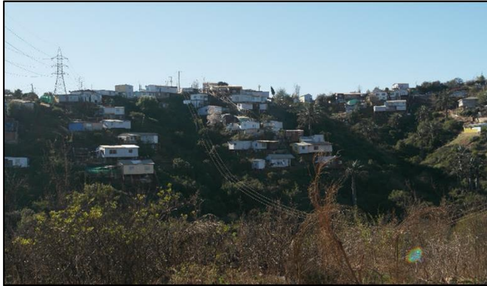
Figura 61: Líneas de alta tensión cercano a Viviendas.
