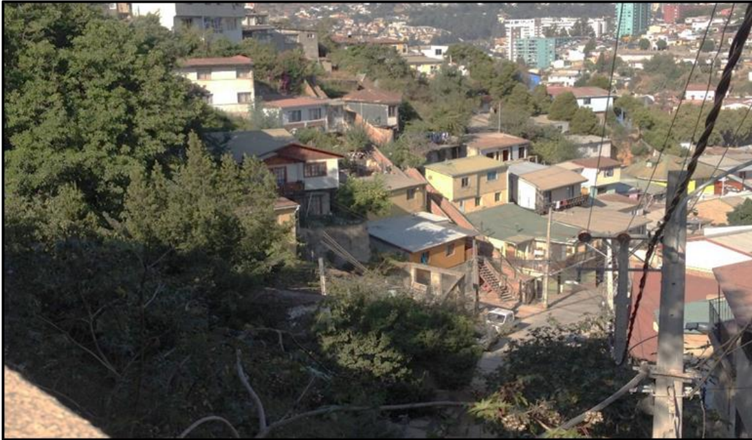
Figura 98: Viviendas ubicadas en laderas, escasos accesos en casos de emergencia.
