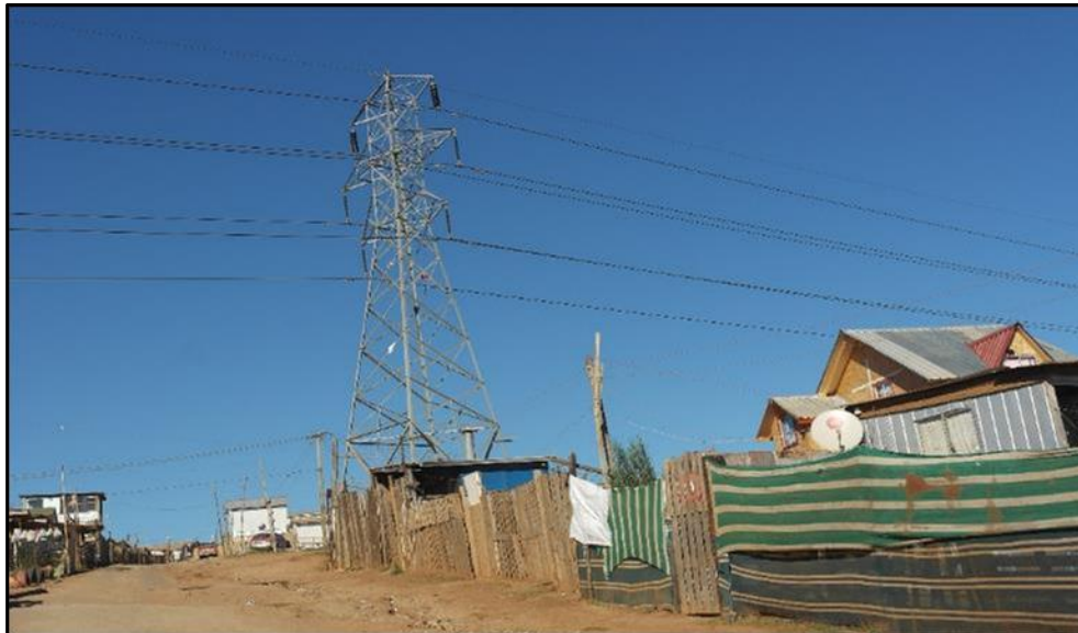
Figura 62: Línea de alta tensión ubicada dentro del patio de una vivienda no regulada.
