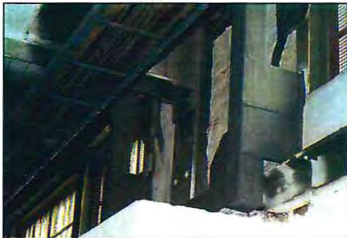
Fotografía 1.19 - Conexión de refuerzo en subterráneo Norte
