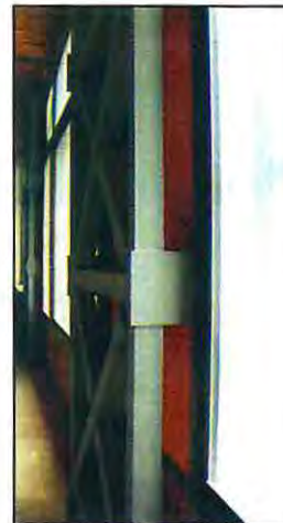
Fotografía 1.16 - Conexión de refuerzo estructural en segundo nivel.
