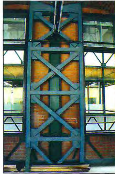
Fotografía 1.15 - Refuerzo estructural primer piso.
