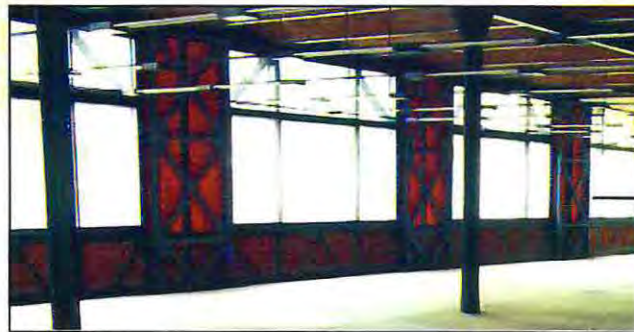
Fotografía 1.7- Refuerzos estructurales del segundo piso, fachada este.
