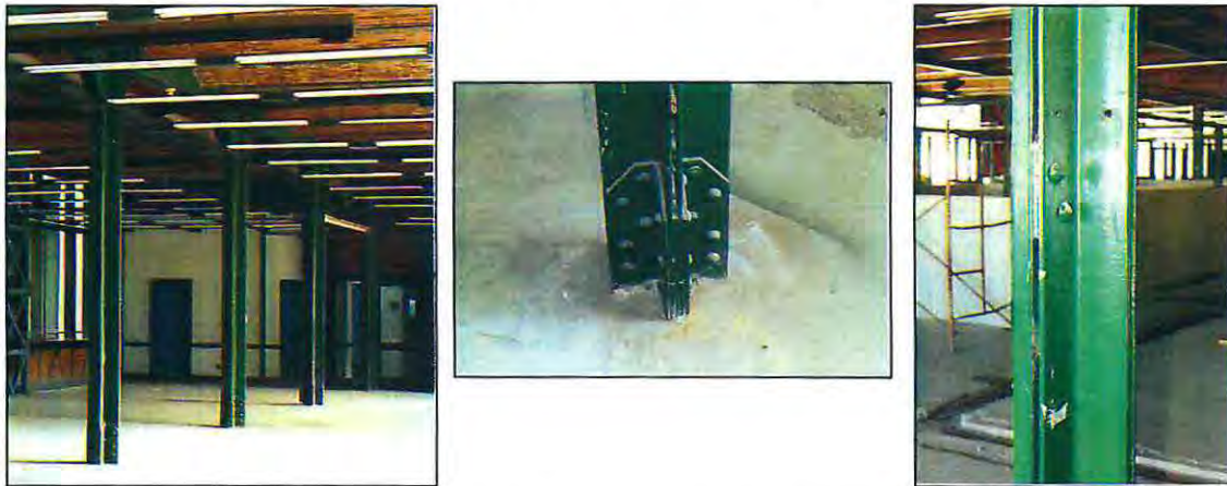
Fotografía 1.10, 1.11 y 1.12 – Unión de columnas cruciformes interiores.
