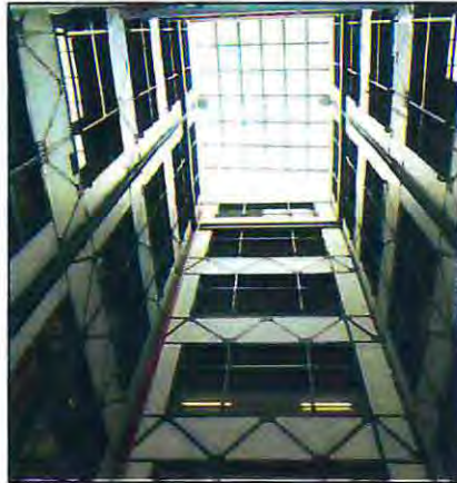
Fotografía 1.14 - Patio interior vista sur.
