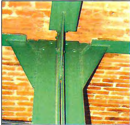
Fotografía 1.17 – Soldadura al oxígeno en planchas.
