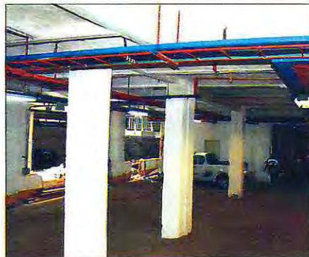
Fotografía 4.3 - Columnas interiores a nivel de subterráneo.
