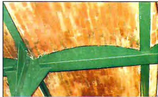
Fotografía 1.9 – Conexión entre vigas.
