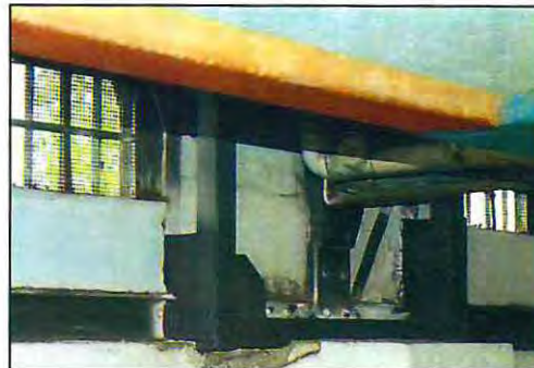
Fotografía 1.20 - Conexión de refuerzo en subterráneo fachada Sur
