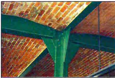
Fotografía 1.2- Planchas de refuerzo en unión viga columna.
