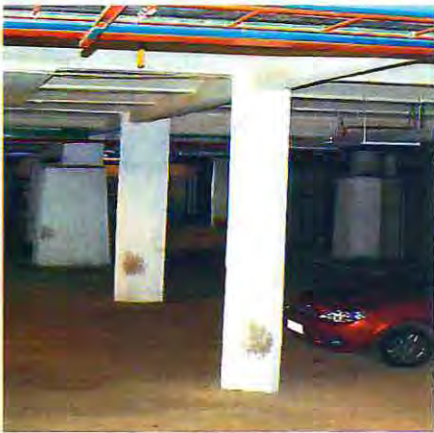
Fotografía 5.1 – Columnas cruciformes en subterráneo.
