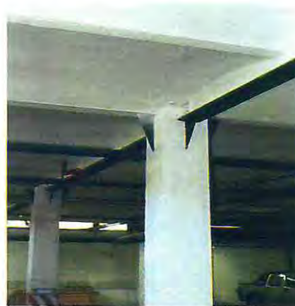
Fotografía 5.2 - Columnas cruciformes en subterráneo.
