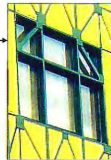
Fotografía 1.4 - Edificio Huckle en el año 2000 y diagonal de refuerzo (Fuente: Diario el Mercurio de Valparaíso).
