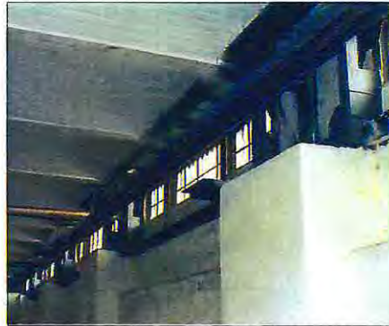
Fotografía 4.2 - Vista interior del muro del subterráneo.
