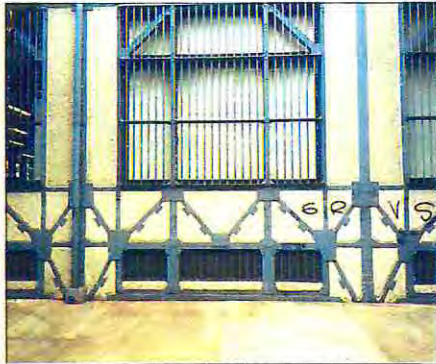
Fotografía 4.1 - Vista a nivel de acera de fachada norte.
