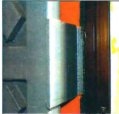
Fotografía 1.18 – Soldadura al arco en refuerzos.
