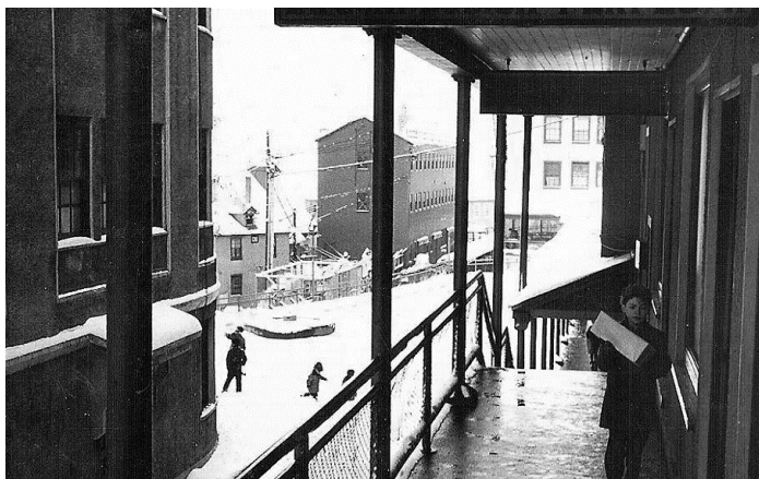
Figura 164 | Corredor exterior en 2 tramos de altura, junto a la plaza Morgan. Sewell, s.f. Fuente: Archivo fotográfico Braden Cooper Company.
