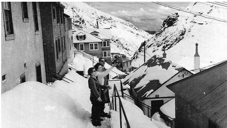
Figura 157 | Visitantes apreciando el paisaje en pasaje de borde, Sewell, s.f. Fuente: Archivo Fotográfico Guillermo Aguirre Rauch
