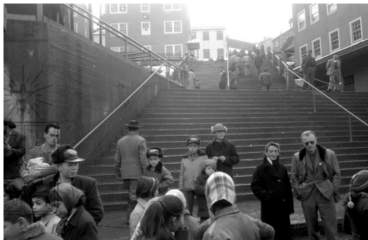
Figura 149 | Escalera central, llegada de ferrocarril, Sewell, s.f. Fuente: Archivo fotográfico Braden Cooper Company.
