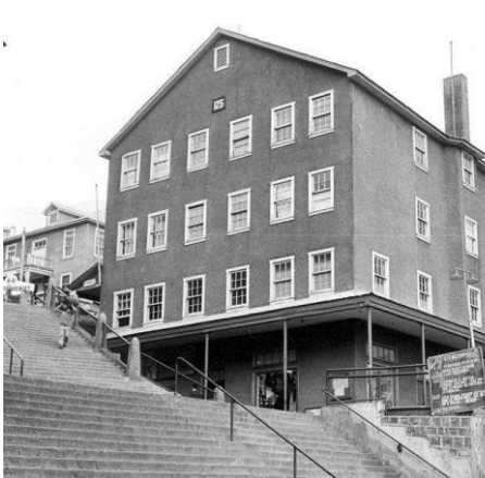
Figura 165 | Corredor exterior que recibe al visitante. Sewell, s.f. Fuente: Archivo fotográfico Braden Cooper Company.
