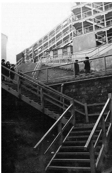
Figura 192 | Contención de terreno en mampostería de piedra. Sewell, s.f. Fuente: Archivo fotográfico Braden Cooper Company
