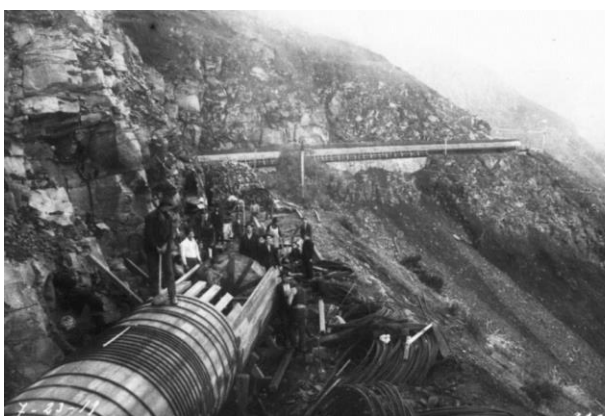
Figura 105 | Construcción tubería de madera, Pangal, 1911. Fuente: Nicanor Ríos, Archivo fotográfico Braden Cooper Company.
