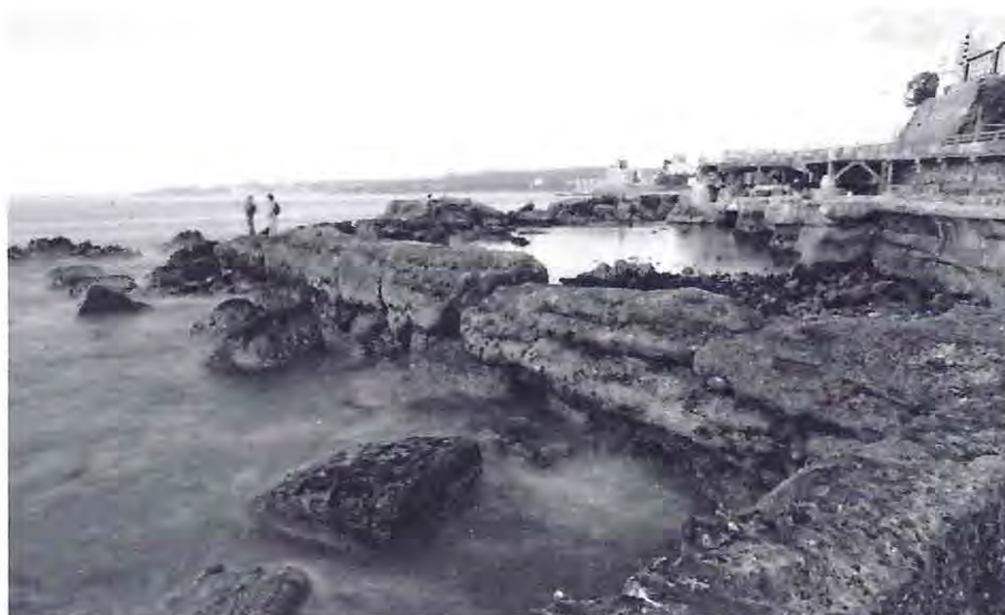
Imagen 131: Ruinas de la antigua piscina pública de Recreo. Viña del Mar.
