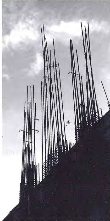
Imagen 124: Construcción en estado inacabado.
