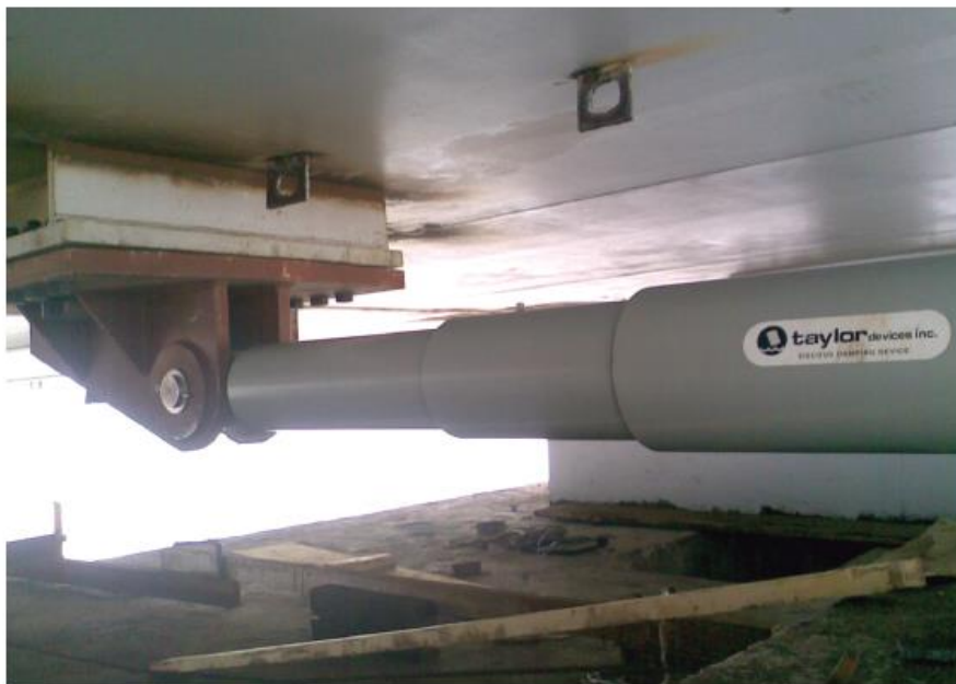
Figura 5.23: Amortiguador viscoso [16].
