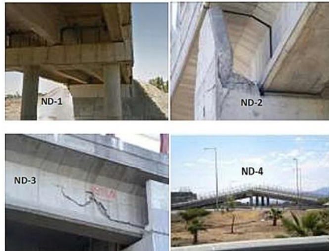
Figura 2.5: Nivel de daño general en pasos inferiores. [2]
