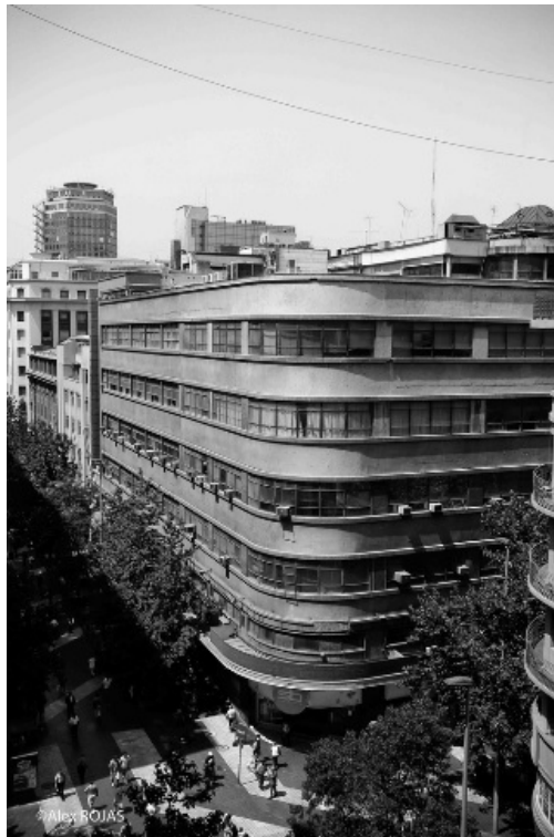
Figura 9: Edificio Oberpaur. Sergio Larraín G. y Jorge Arteaga (1929), primer edificio de Arquitectura Moderna en Chile. Es evidente la limpieza de la obra y cuanto difiere del estilo francés. Se presenta una estructura continua, y de planta libre.
