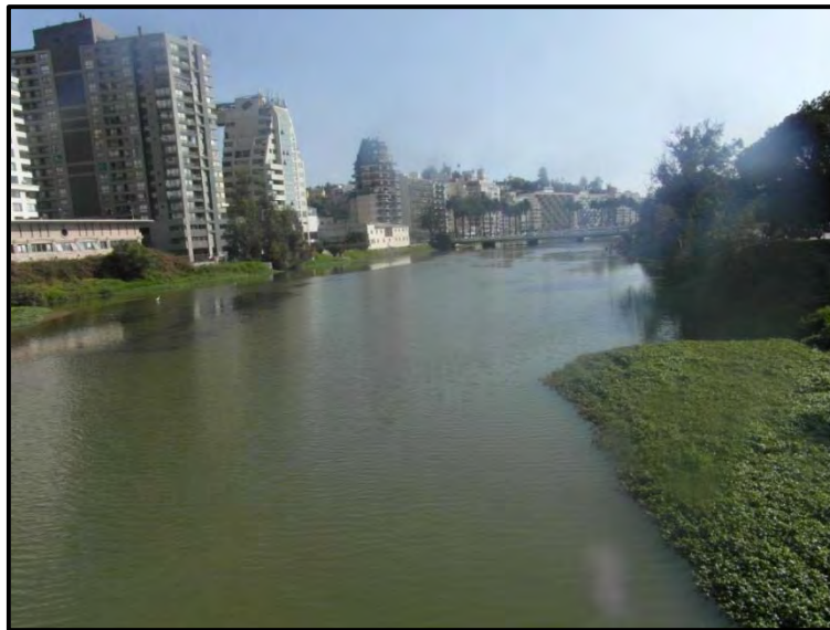
Figura 4.4 - Estero Marga Marga, entre puente Villanelo y puente Ecuador.
