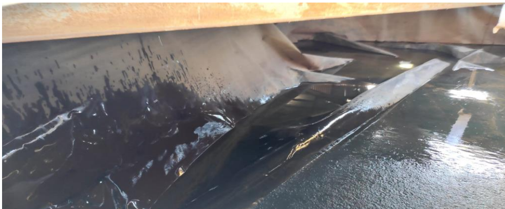
Figura 3-16: Tanque de almacenamiento implementado en la planta de tratamiento
