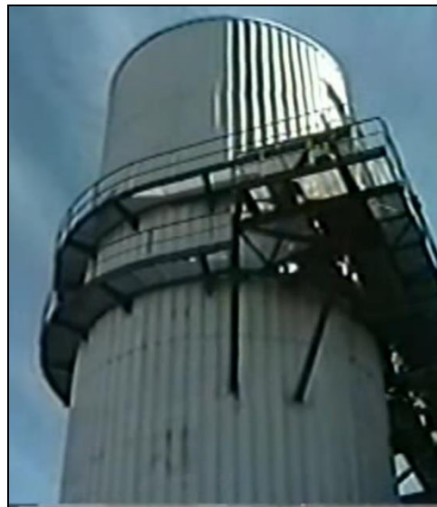
Figura 5: Torre de Extracción
