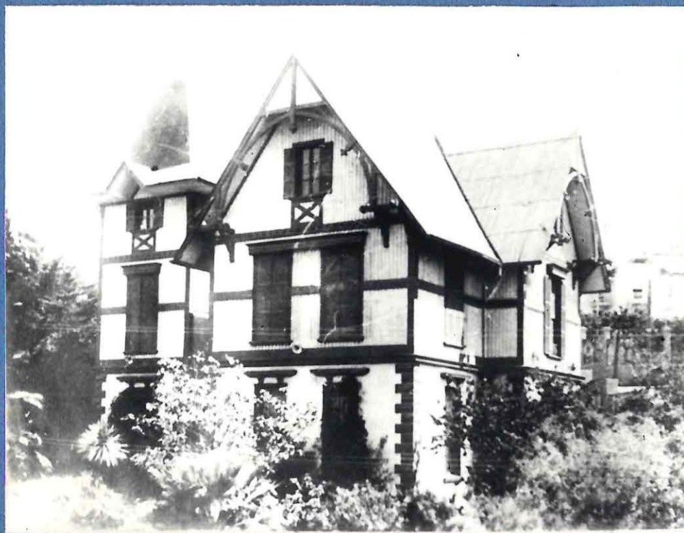
Foto 1: La casa en 1939 aproximadamente
