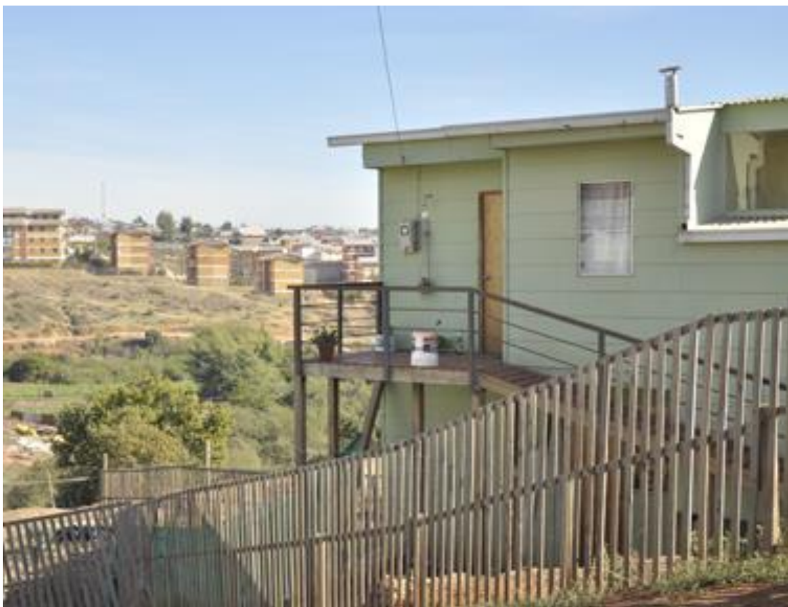
Vivienda del conjunto “Newen Ruka”, en la parte superior derecha se puede observar el tragaluz.
