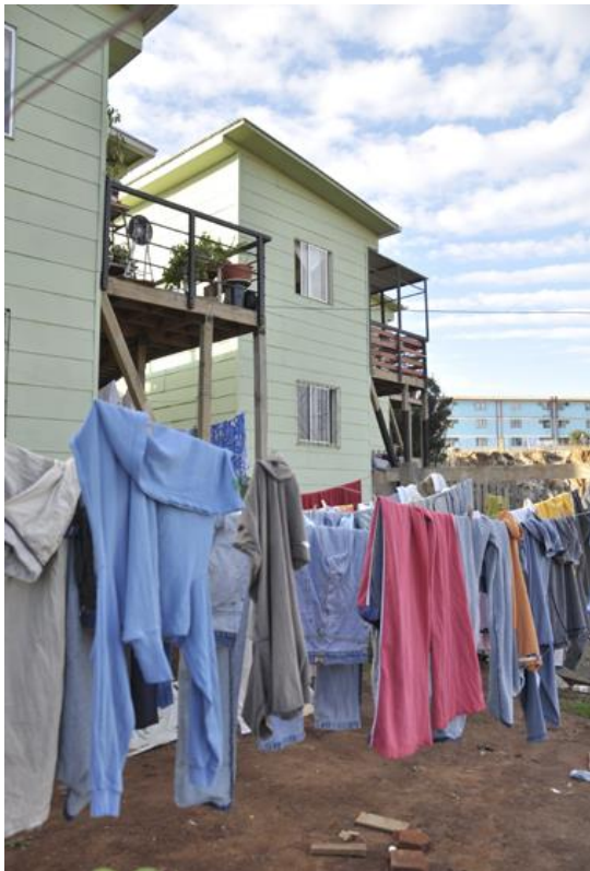
Balcon para ampliación en vivienda del Conjunto “Newen Ruka”
