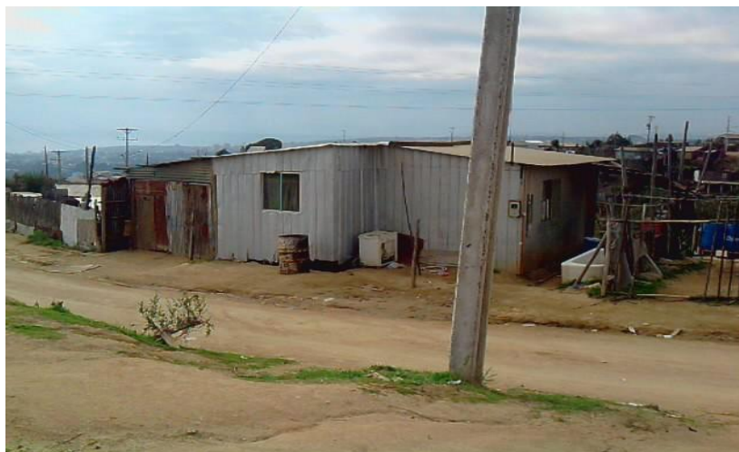
Fotografía 3.1: Dependencias del Asentamiento Humanos Precario Sor Teresa
