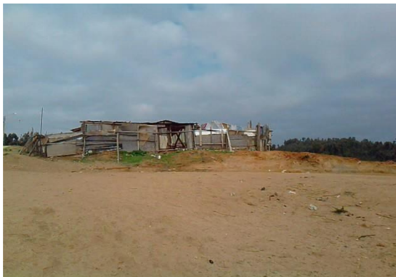
Fotografía 3.3: Dependencias del Asentamiento Humanos Precario Sor Teresa
