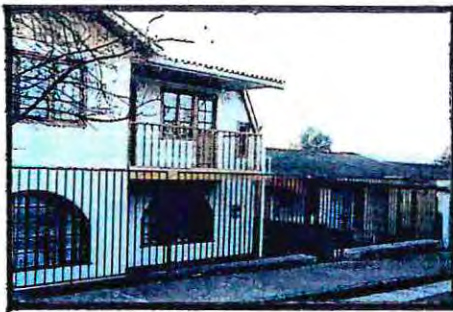
Casa de material sólido
