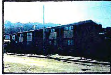
Conjunto Viviendas Básicas
