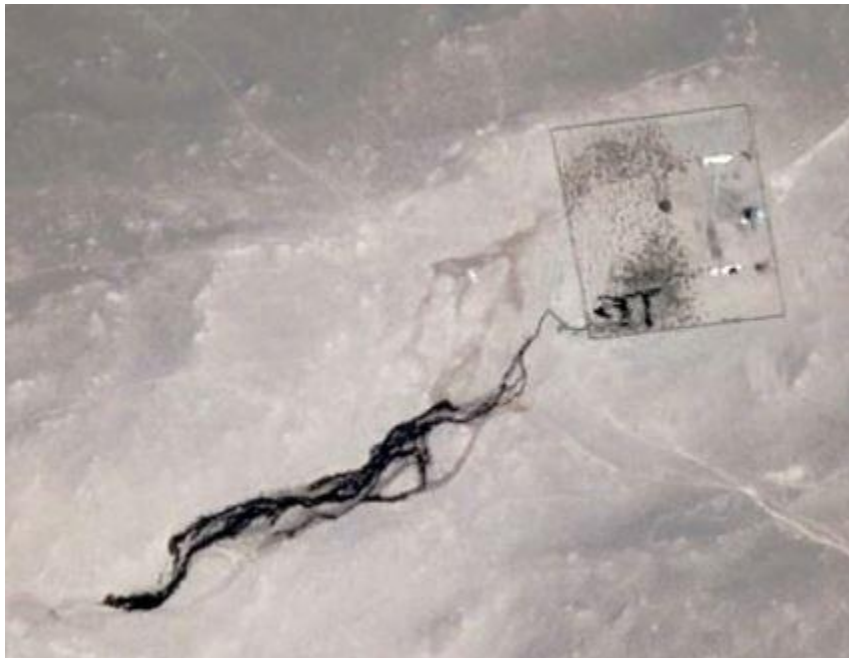
Ilustración 1.4.- Imagen satelital de planta de tratamiento actual de Toconao. Fuente: Google Earth [6].
