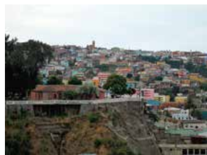
Fig. 24, Vista de los antiguos cimientos
