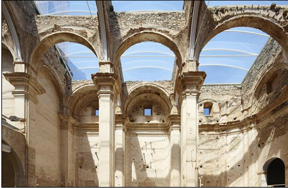
Imagen 43 Restauración Iglesia ST. Pere, ejemplo de membrana simple. Fuente: sciELO.conicyt.cl
