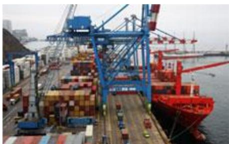
iniciaron el 1 enero 2000. El terminal cuenta con moderno equipamiento: 1 Gantry Super Post-Panamax, 2 STS Gantry Panamax, 2 STS Gantry Post-Panamax, 2 Grúas GOOTWALD, 12 Grúas de patio RTG, Reachstakers, Top Lifters y tractocamiones.
