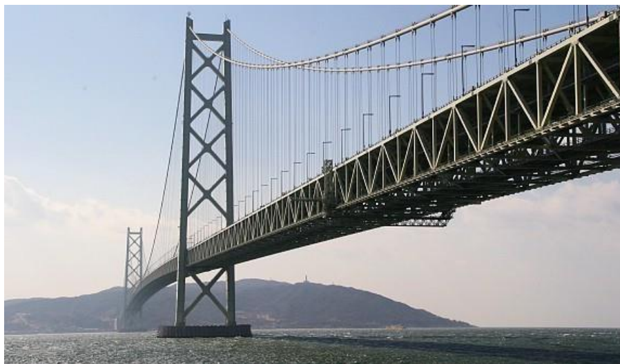
Ilustración 12: Puente en suspensión Akashi Kaikyo
