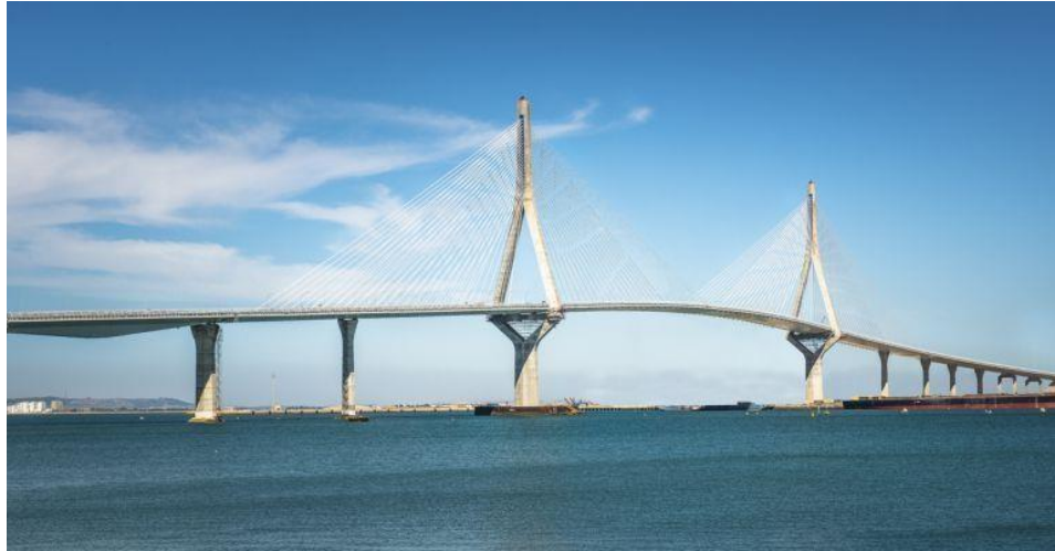
Ilustración 14: Puente de la Constitución de 1812
