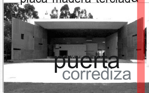
estructura perfiles metálicos revestimiento placa madera terciada
