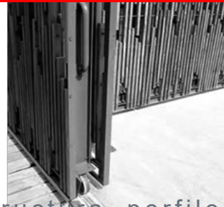
estructura perfiles metálicos revestimiento placa madera terciada
