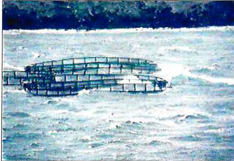
Figura 74: Comportamiento de jaulas flexibles en condiciones de mar abierto
