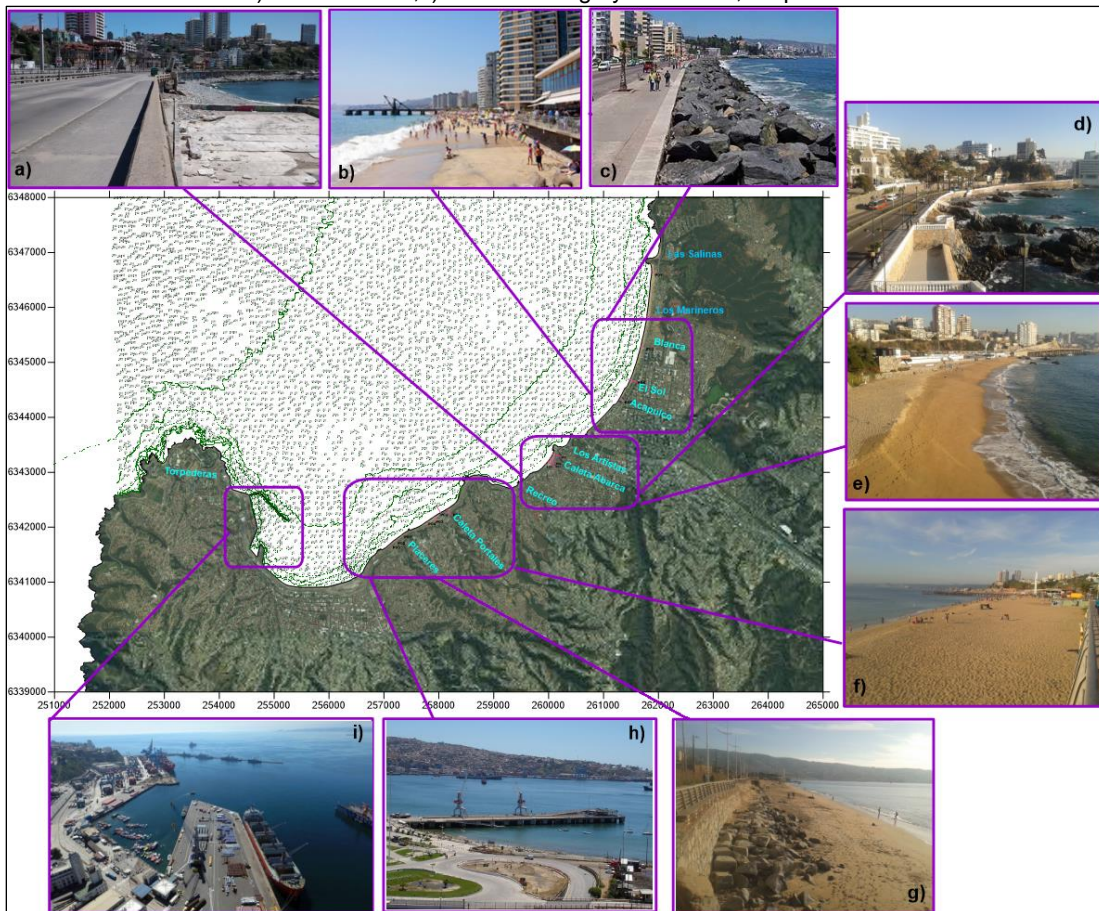
Figura 1-1: Algunas estructuras presentes en el borde costero de Valparaíso y Viña del Mar. a) Piscina de Recreo, b) Obras en playa Acapulco, c) Obras en Avenida Perú, d) Avenida Marina, e) Paseo costero en playa Caleta Abarca, f) Muelles de pescadores en Caleta Portales, g) Paseo Wheelwright, h) Muelle Barón, i) Molo de abrigo y terminal II, Valparaíso.
