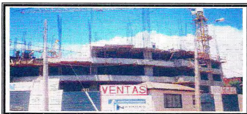
Obra Construcción "Puerto Cisnes" Empresa Nahmias Hnos.
