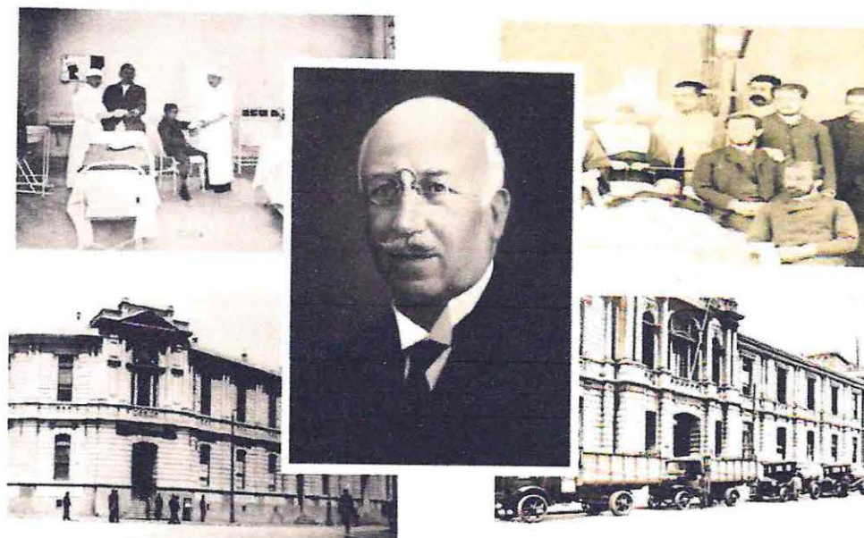
Imagen N°4: Hospital Carlos Van Buren, Patrimonio de la Salud Chilena 4
