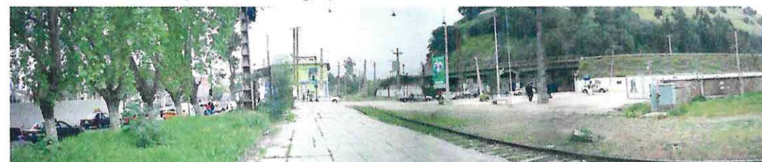
Imagen 7. Acceso a La Calera desde el andén del tramo Valparaíso-Santiago.
