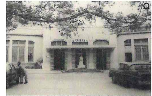
Imagen 11. Acceso Estación de Calera
