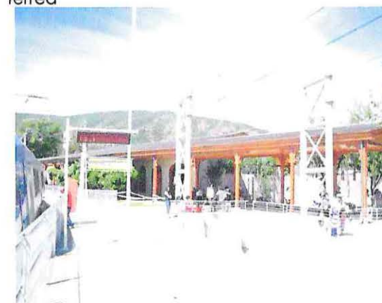
Imagen 11. Nueva estación desde la línea férrea
