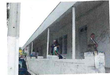
Imagen 7. Estación de Quilpué, con el corredor en altura enfrentando la plaza Irarrazabal, fachada singular que contiene el espacio de la plaza, diferenciándose de las demás envolventes.
