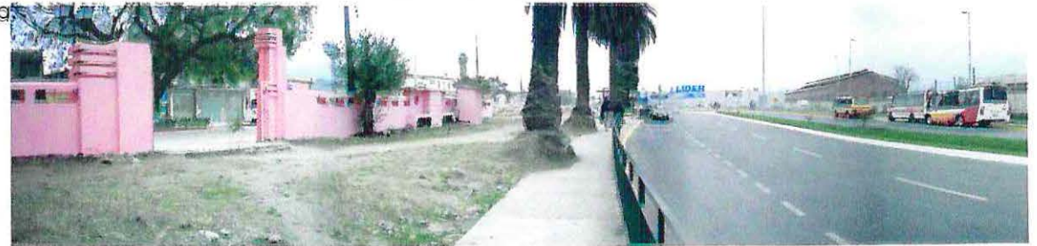
Imagen 23. Muros de la ex Estación mirando hacia el trocal - calle Condell -, vía de circulación de locomoción interurbana.
