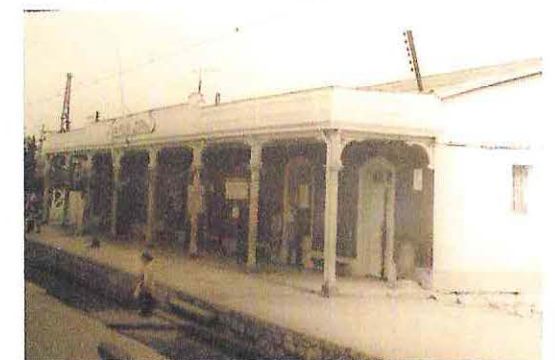
Imagen 18. Estación de San Pedro en funcionamiento
