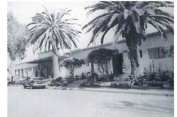
Imagen 17. Acceso con alero
