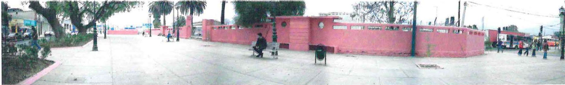
Imagen 22. Bandejón y muros de cierre de la ex Estación de Quillota.
