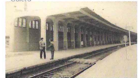
Imagen 12. Andén Valpo-Stgo, cubierta de pórtico que sostiene losa en volado.
